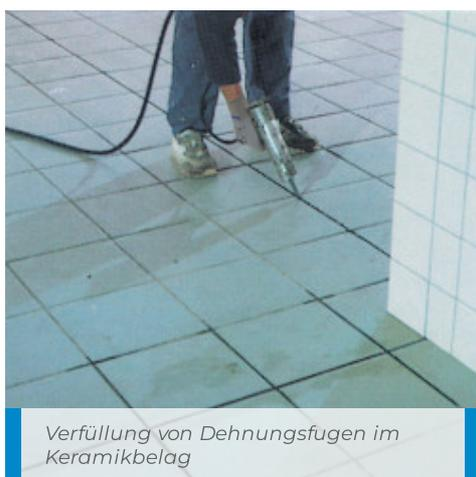
Verfüllung von Dehnungsfugen im Keramikbelag
