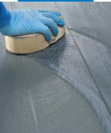
Endreinigung des Fugenmörtels mit einem Schwamm
